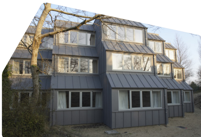
Vakantiecentrum Ter Helme, België Aspect: QUARTZ-ZINC® PLUS
